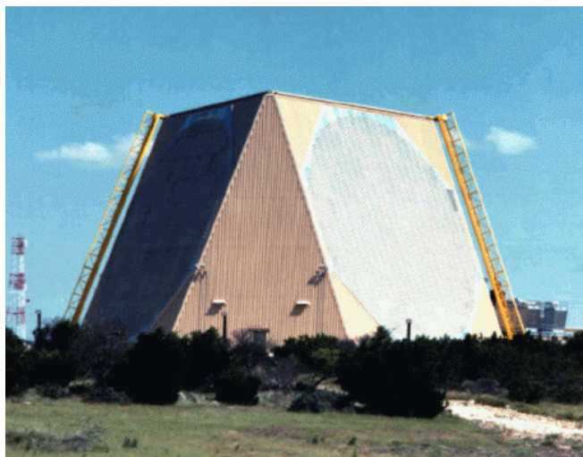
Радар за ранно предупреждение Upgraded Early Warning Radar (UEWR)
